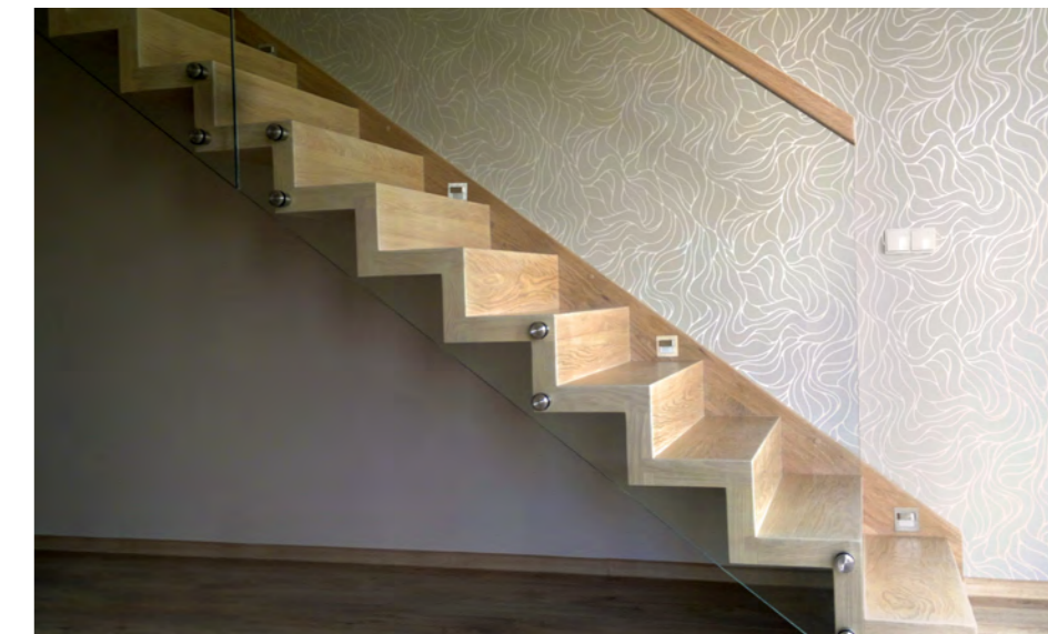
FALTWERKTREPPEN, GELÄNDER BEFESTIGT AUF KUGELGELENKEN
