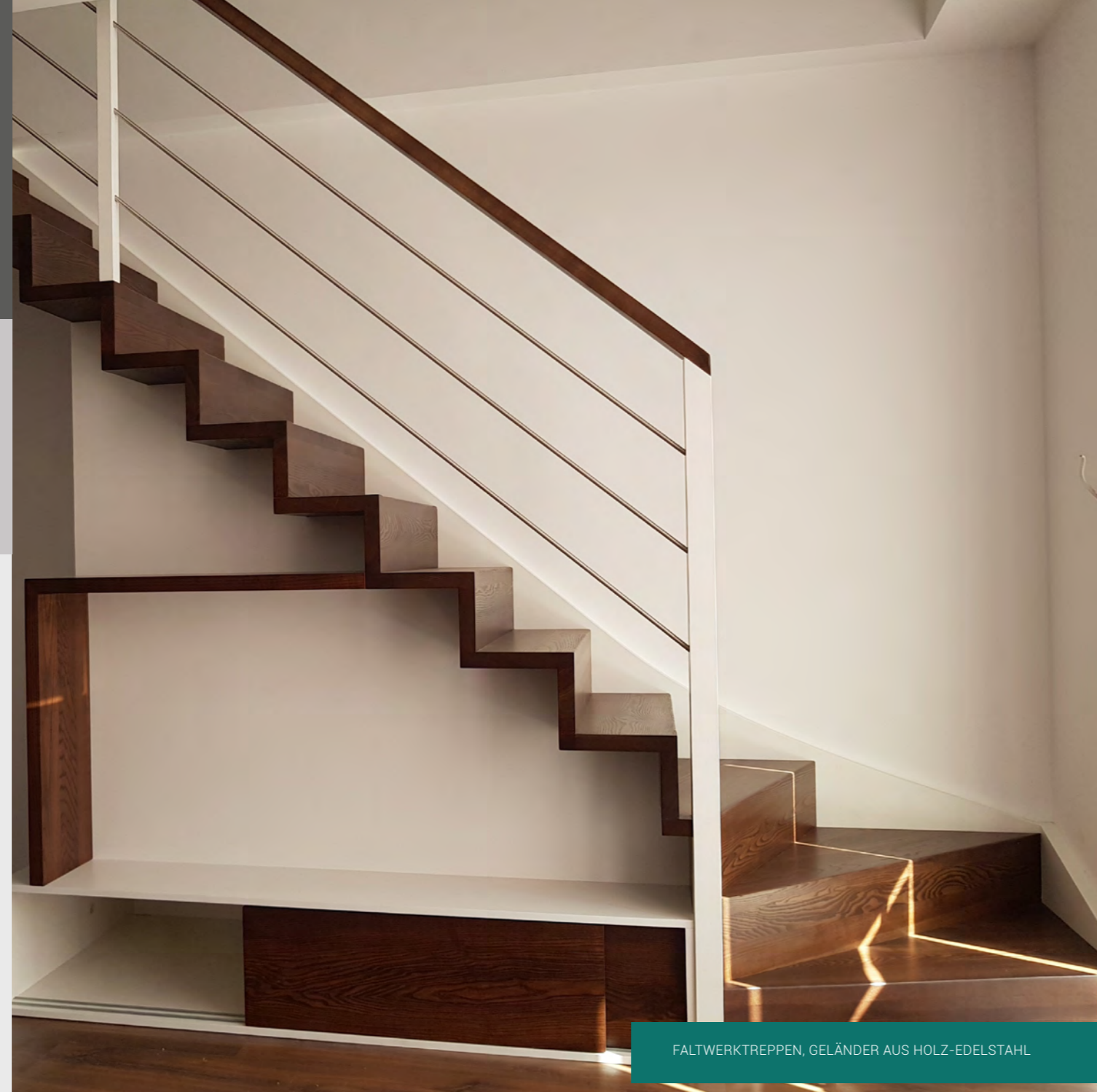
Faltwerktreppen mit der Wange an der Wand mit 6 cm Dicke
