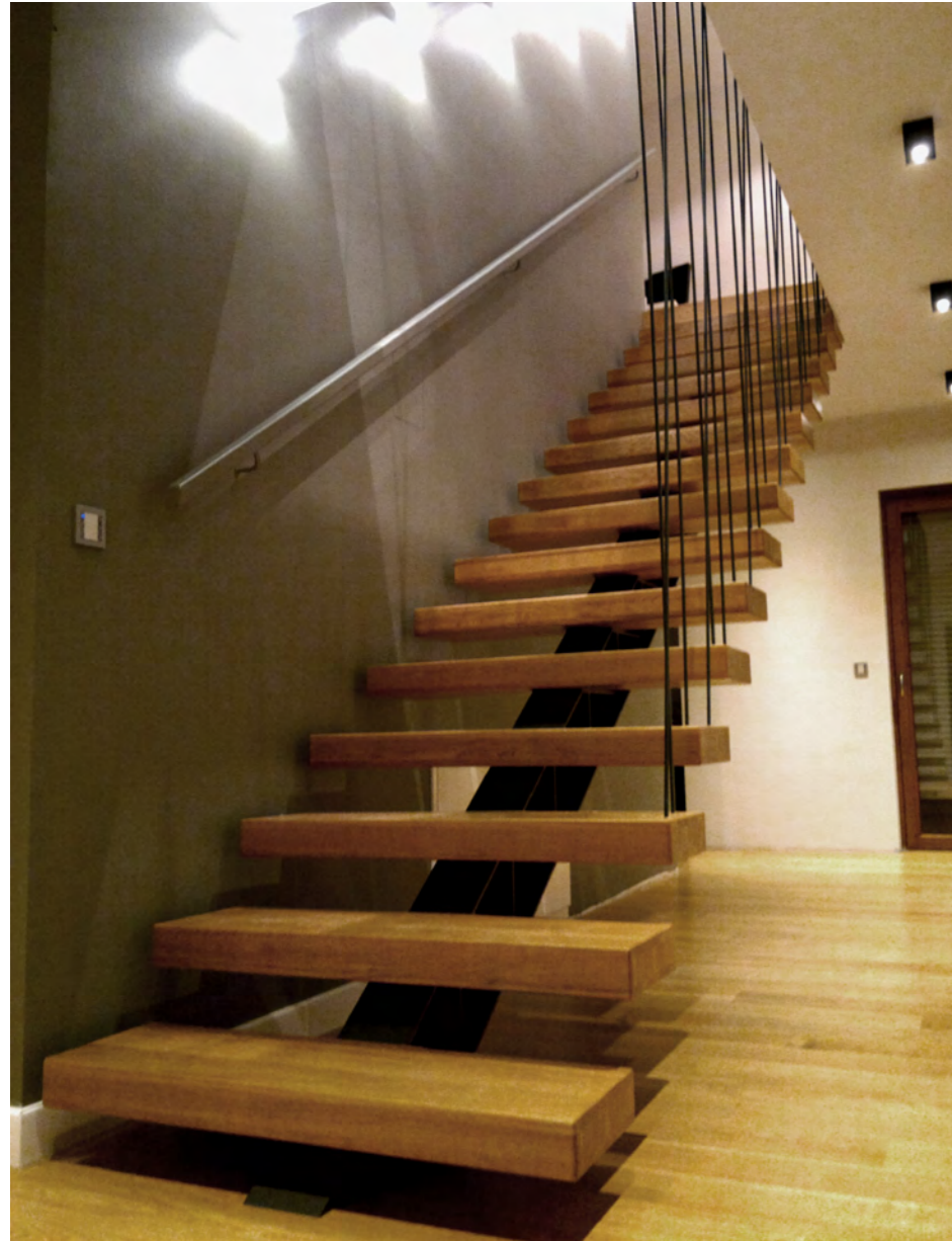
TREPPEN MIT DEM ZENTRALBALKEN, MODERNES GELÄNDER, BEFESTIGT AN DER DECKE
