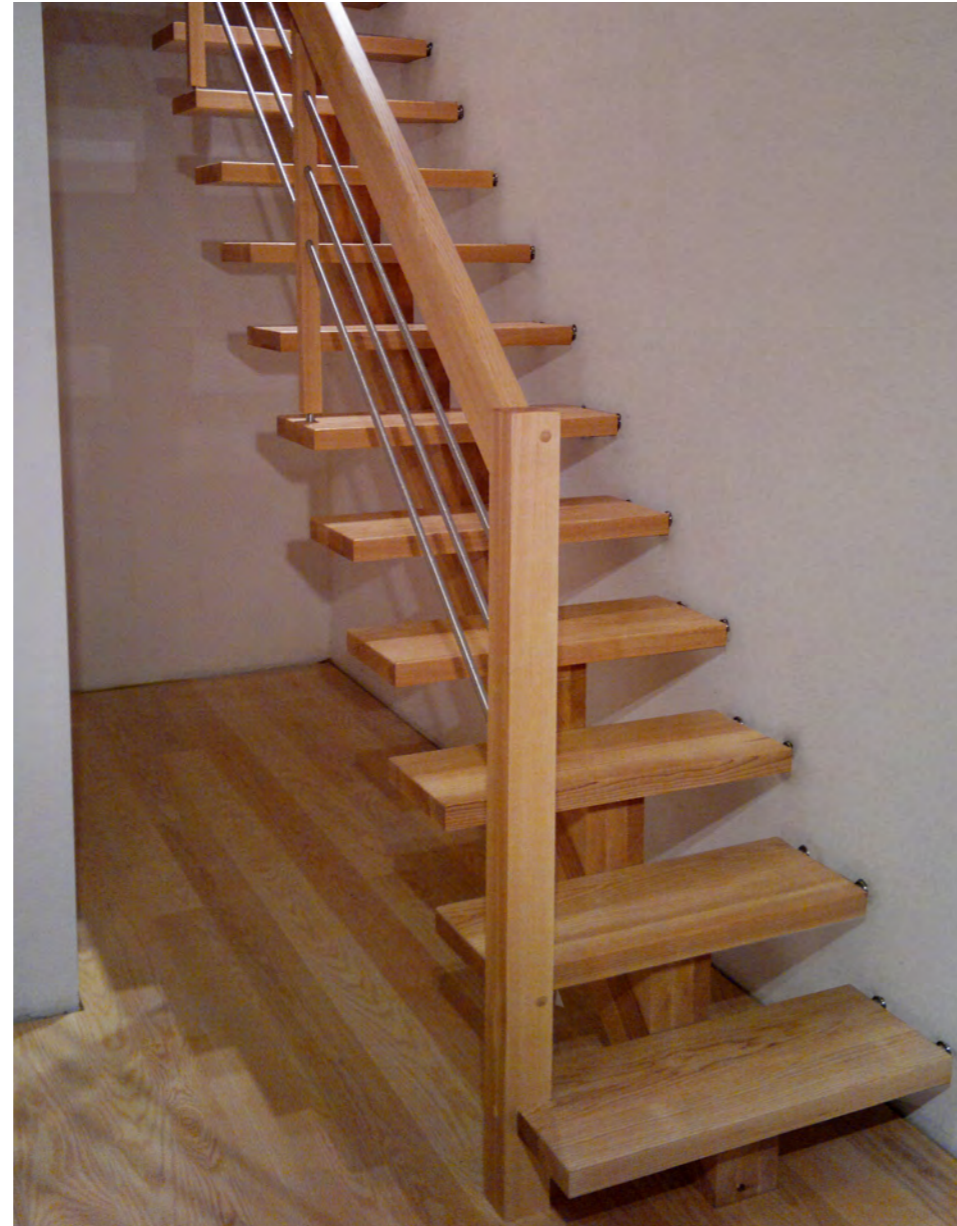
TREPPEN MIT DEM ZENTRALBALKEN, GELÄNDER AUS HOLZ-METALL
