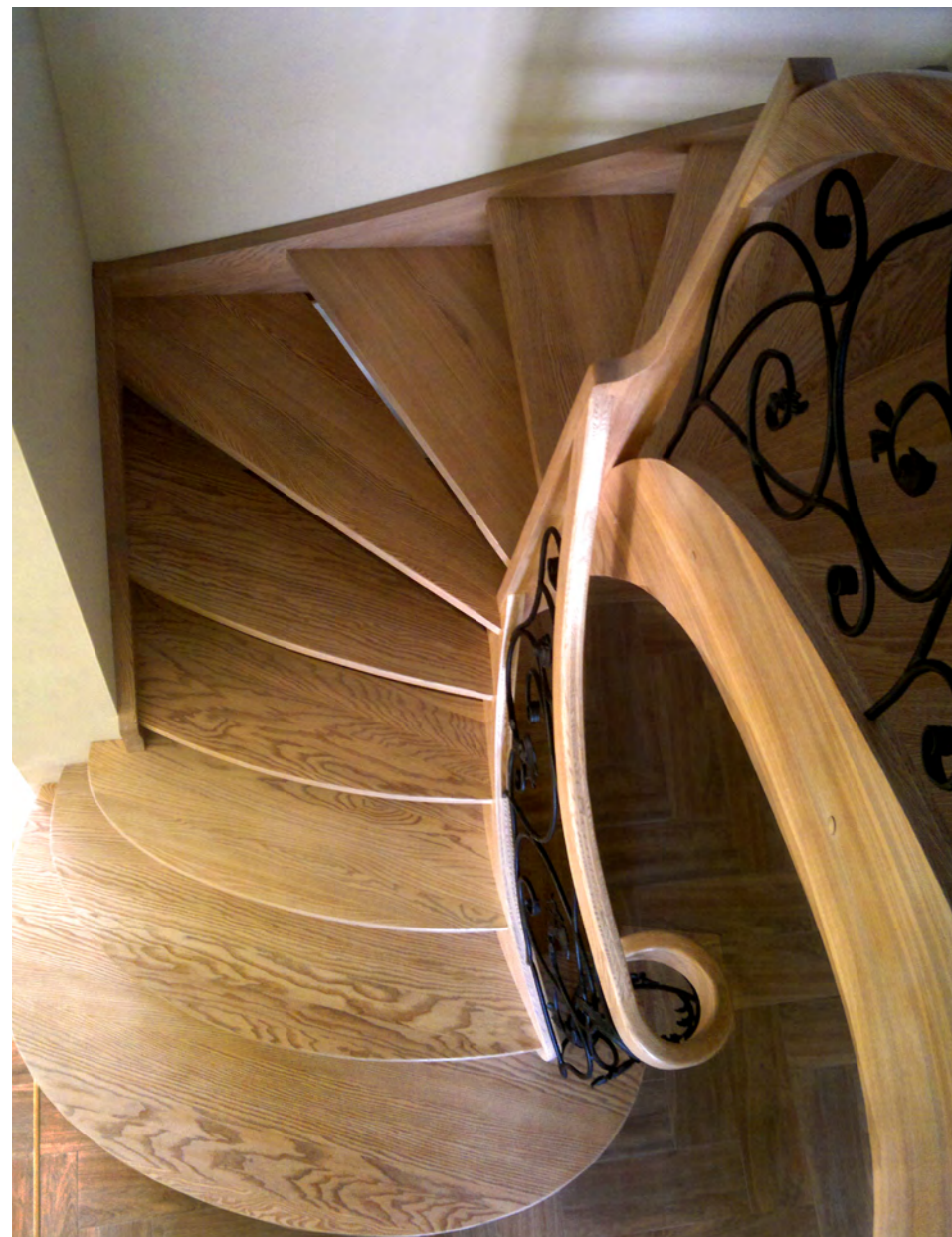
SCHODY POLICZKOWE AŻUROWE, BALUSTRADA STALOWA-KUTA
