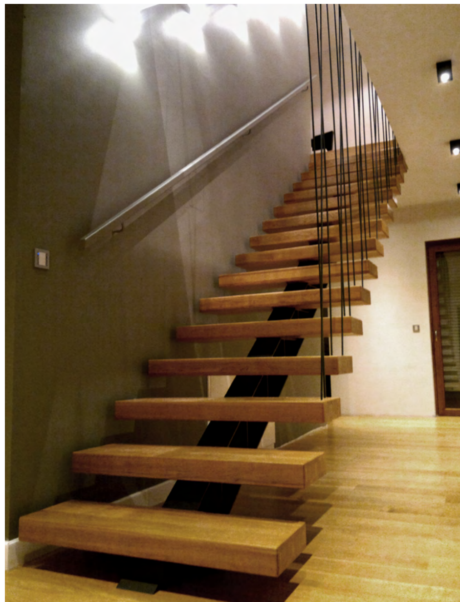
SCHODY NA STALOWEJ BELCE CENTRALNEJ, NOWOCZESNA BALUSTRADA PODWIESZANA DO SUFITU
