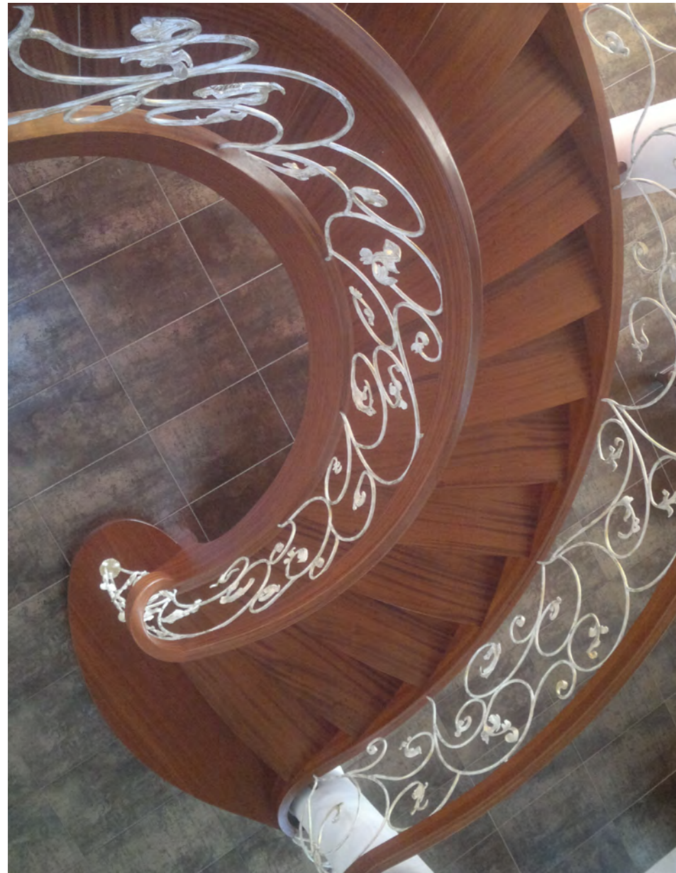
SCHODY GIĘTE, DREWNO SAPELI
